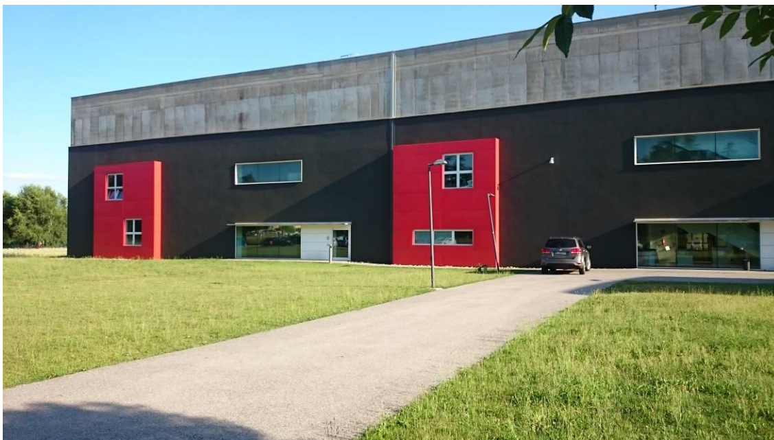
Fronte nord, in alto la zona di intervento - corpo B3
