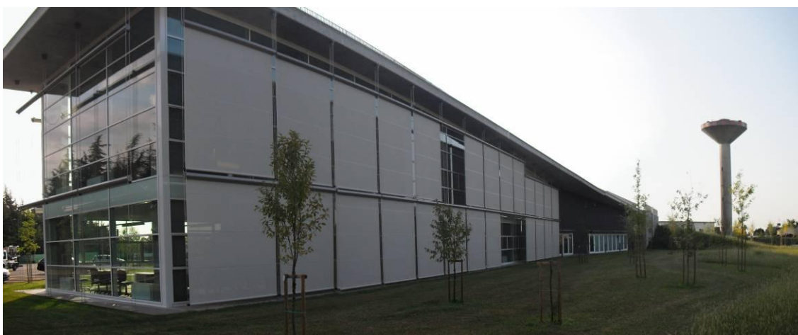
Fronte principale su via Roveredo – corpo C
