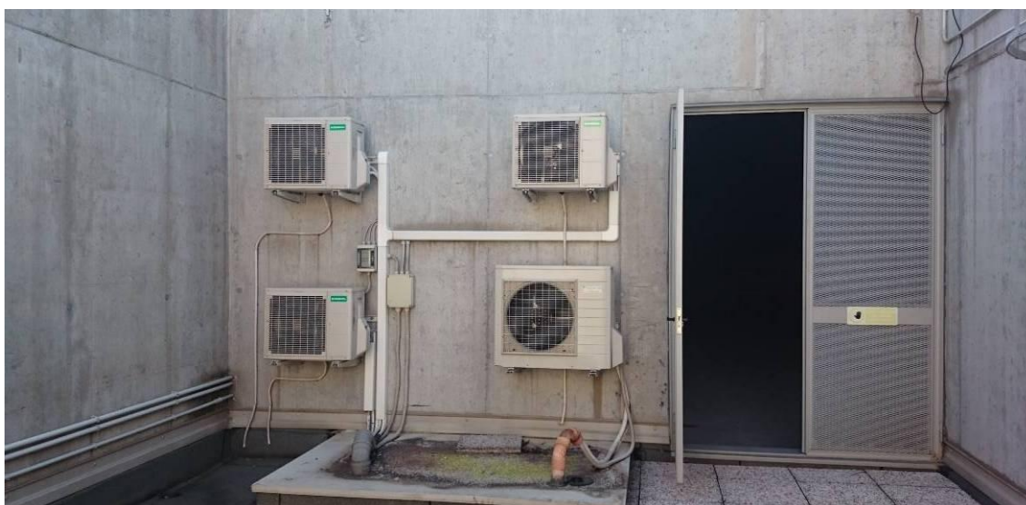
Ingresso al locale oggetto di intervento dallo spazio esterno in copertura
