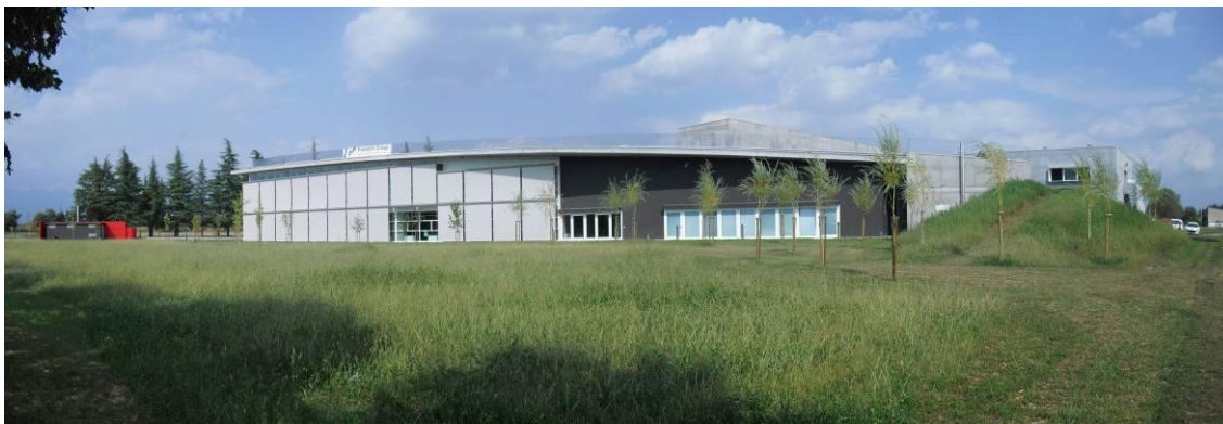
Prospetto principale lungo il fronte strada - corpo C
