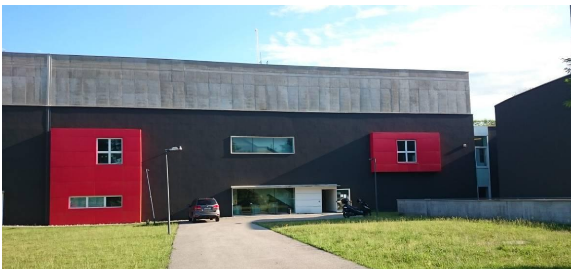
Fronte nord, in alto la zona di intervento corpo B3
