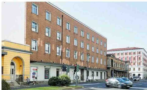
La rossa mole di Urban center in corso Cavour
